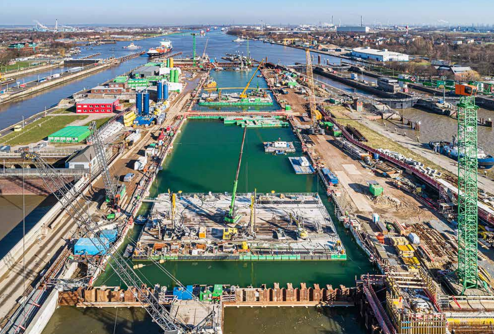
Bau der 5. Schleuse in Brunsbüttel
