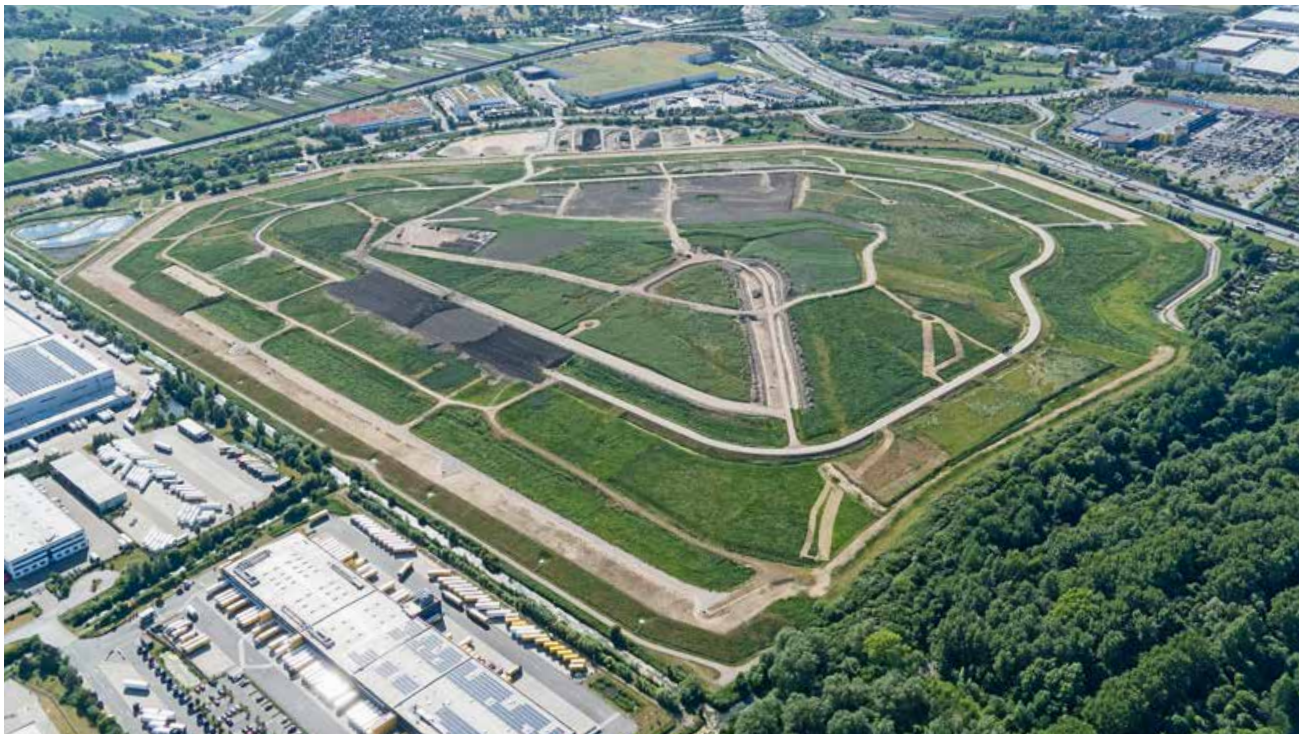
Belastete Sedimente aus den Hafengewässern werden aufbereitet und an Land fachgerecht gelagert.
